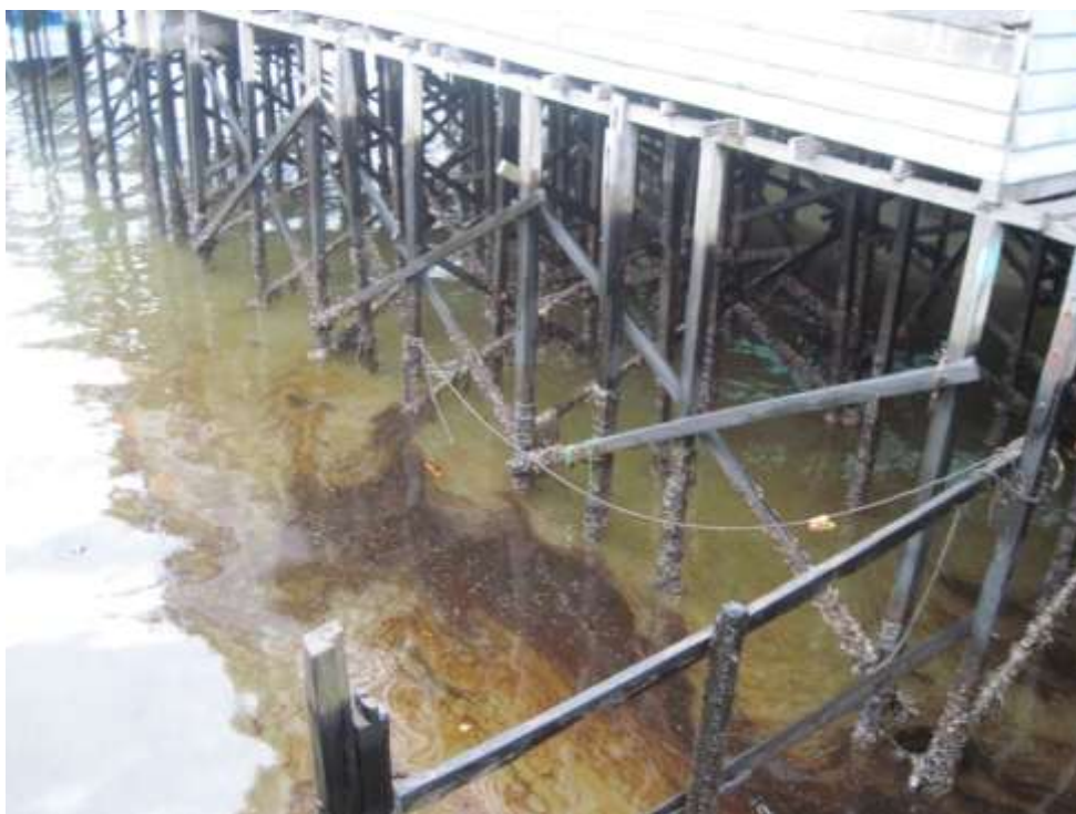
Foto Kondisi Perumahan Pasang Surut Kampung Baru, Balikpapan.
